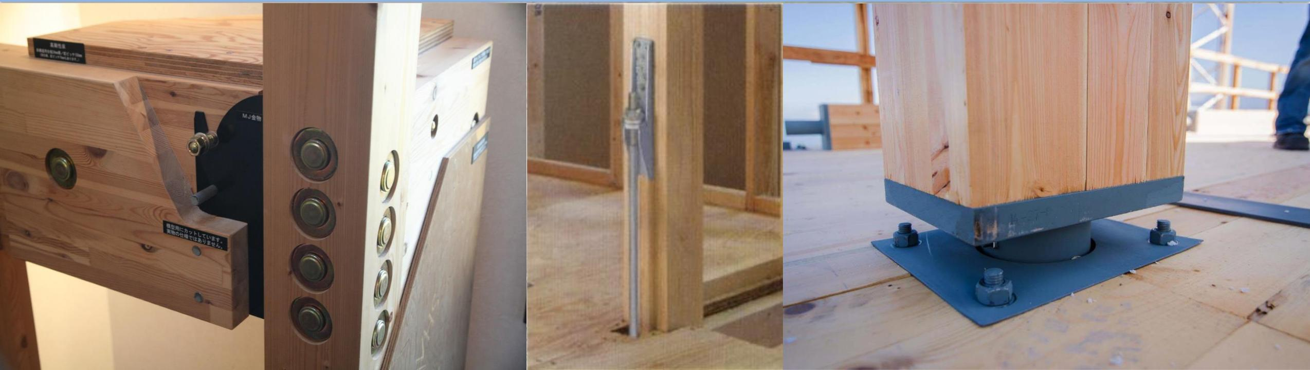
Различные коннекторные соединительные элементы дают сочетание удобства для сборки-разборки, эстетичности и надежности. Кроме того, они делают конструкции более сейсмостойкими
